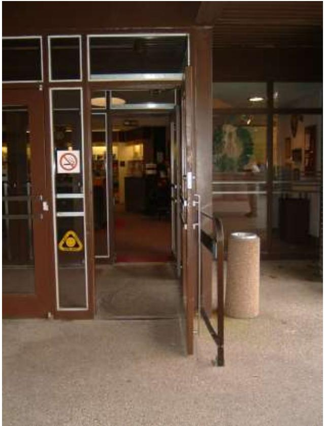
ビジターセンター入口のドア。VCには両開き2組、片開き2枚のドアがあるが、そのうち片開き1枚のみ自動ドア兼用とされている。右下の手すり手前側にボタン（青色）がついていて、それを押した場合のみ自動で開閉するしくみ。内側のドアと外側のドアは連動している。
