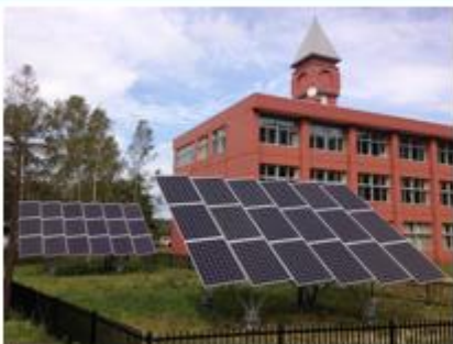
避難所に設置した太陽光発電
