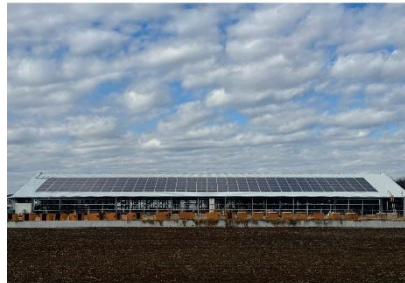
太陽光パネル
