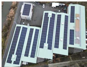
太陽光パネル
